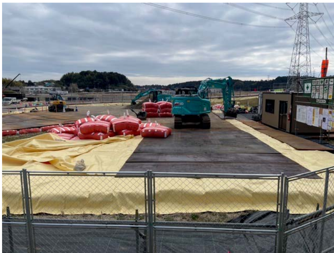
写真1：D・Boxを敷設し、上部にPPシート設置後敷鉄板を敷設する。
